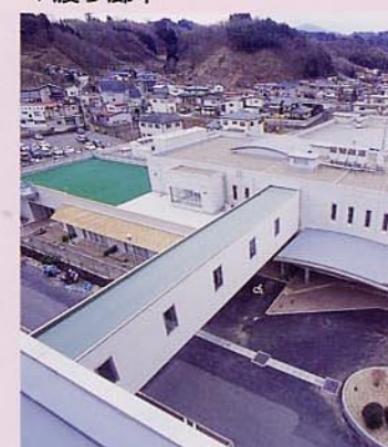
(病院へつながる連絡通路)
